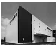
2015年2月に竣工した第一工場生産棟。GMP適合の最新設備を完備
